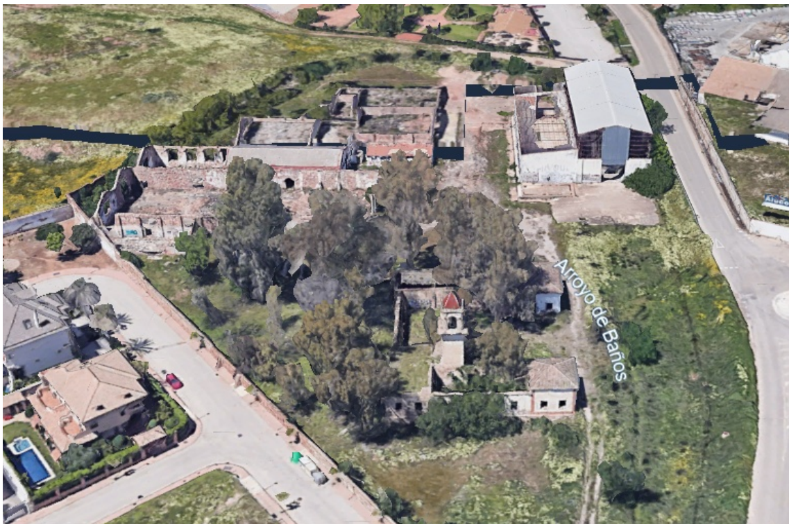
Fig.16 : Vista general del conjunto de las cocheras del tranvía, antes de la demolición del Templo (Google Earth).
