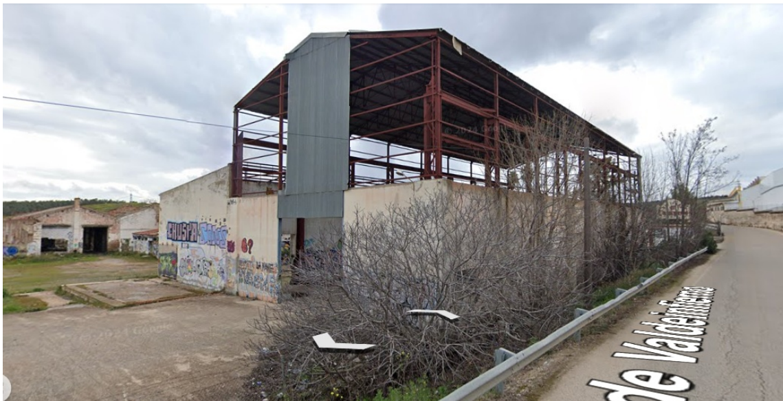
Fig. 14: Vista del Templo en dirección Santuario de Linarejos-Pista de Valdeinfierno, antes de su demolición (Google Earth).
